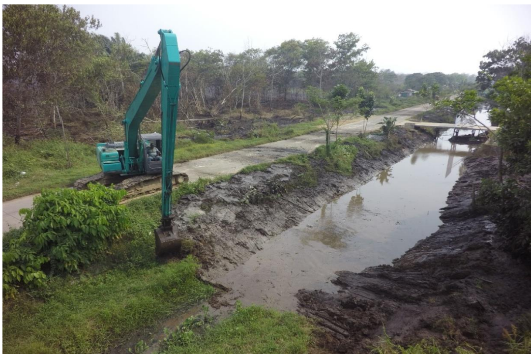
Eksavator milik Dinas PUPR saat melakukan pengerukan parit di Jalan Perdana. (Dok: BPBD Kota Pontianak)
